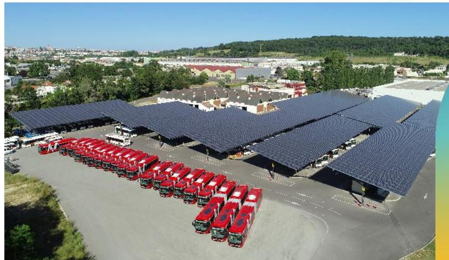
Technique Solaire a développé ces ombrières photovoltaïques en partenariat avec le Grand Angoulême. Ces 10 000 m<sup>2</sup> de toitures sont installés sur le parking des bus de la Société de Transport du Grand Angoulême (STGA). Cette centrale a une puissance de 1,9 MWc.
