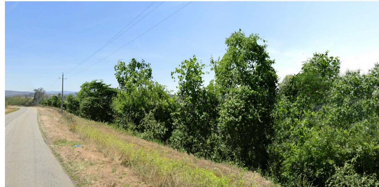
Insertion paysagère avec mesures paysagères (haie en recul de la ligne électrique)
