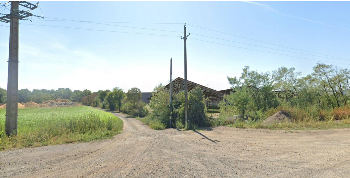
Insertion paysagère sans mesure paysagère (réduction de la hauteur et renforcement de la haie)
